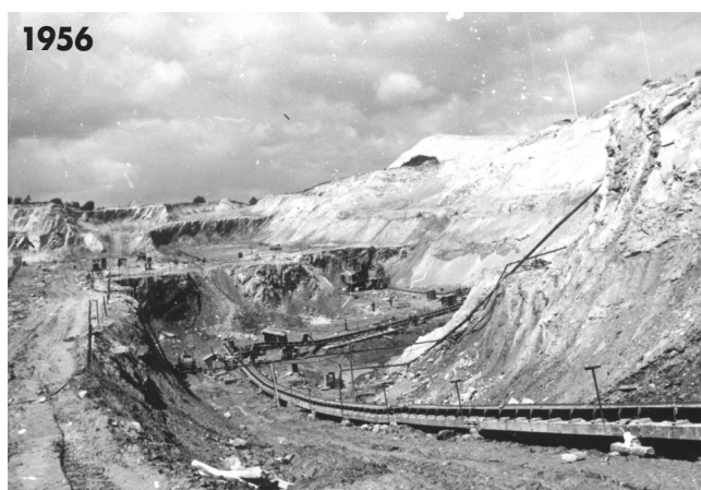
Photo 1 - Vue partielle de l'open-pit du Bois-Vert. Au fond, cinquième niveau. Transport des stériles du minerai par bandes (L. Chauris, 1956)
