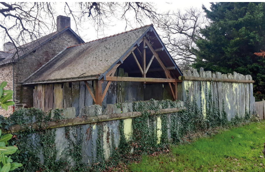
Photo 4 - Habitat et clôture réalisés en Pierre Bleue (Nozay)
