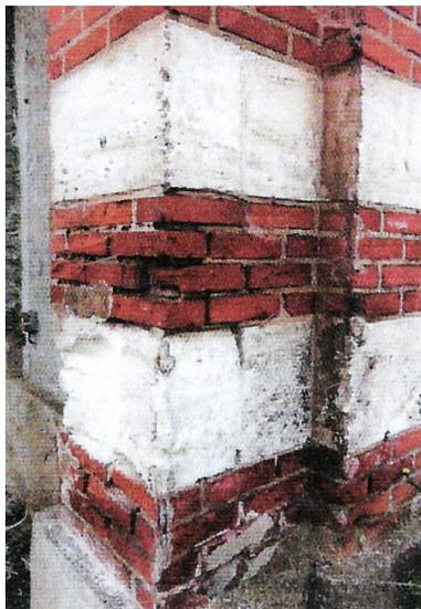
**Photo 6 - Un des bâtiments de la gare de Quimperlé : alternance brique rouge et tuffeau blanc altéré**
