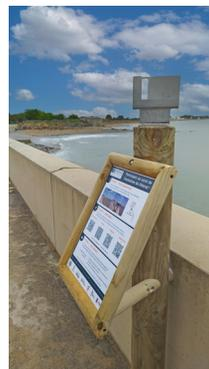
**En couverture** : Exemple de support inox mis en place pour la prise de photographies par smartphone dans le cadre du dispositif CoastSnap (ici à la plage des Homardiers, Île de Noirmoutier)
