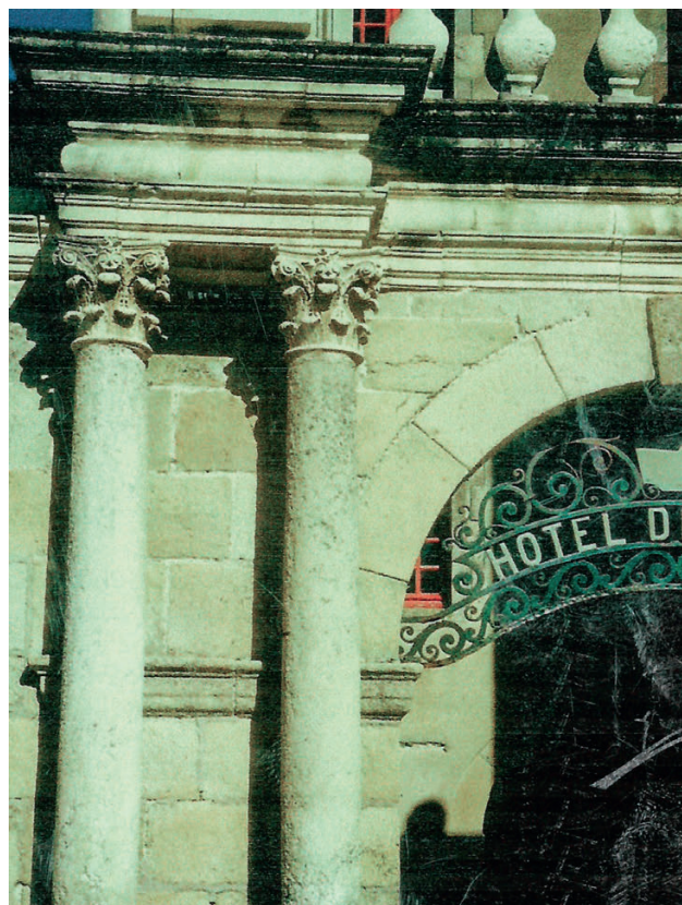
Photo 8 - Hôtel de ville du Croisic (ancien Hôtel d'Aiguillon) ; deux colonnes monolithes en leucogranite pegmatitique ; chapiteaux en calcaire [de Charente ?]
