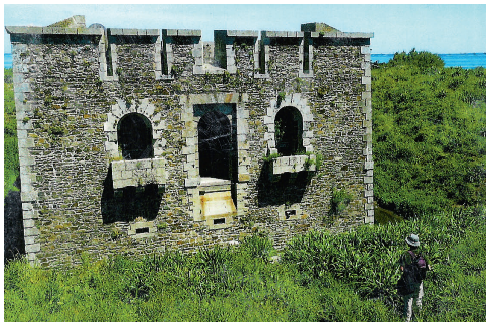
Photo 6 - Réduit de l'île Dumet : pierres de taille en granite et en calcaire ; moellons en micaschiste de provenance locale
